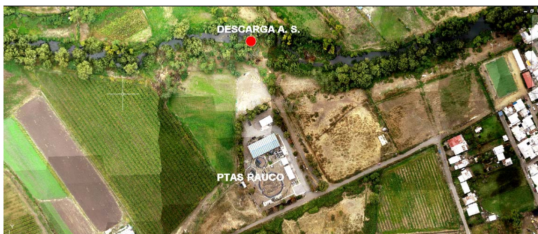
Figura 10. Planta de Tratamiento de Aguas Servidas de Rauco y descarga a estero Comalle.
